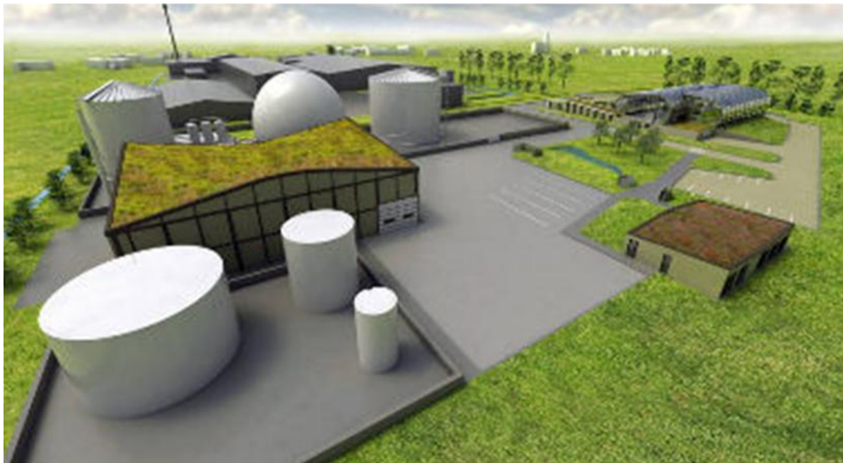
Εικόνα 2.4-6: Μονάδα Αναερόβιας χώνευσης στο Cambridgeshire (UK) δυναμικότητας 30.000 τον./έτος.
