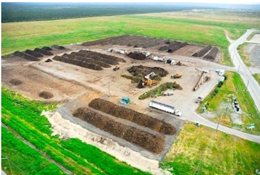
Εικόνα 2.4-4: Κεντρική μονάδα κομποστοποίησης αποβλήτων κήπου (τύπου 1) στον Καναδά (City-Wide Composting, Vancouver), δυναμικότητας 45000 ttn/year και απόδοσης 18000 tn/year compost
