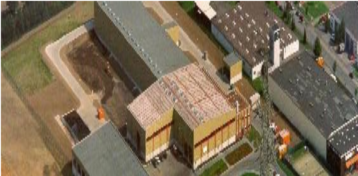
Εικόνα 2.4-5: Μονάδα κομποστοποίησης βιοαποβλήτων (τύπου 2) στο Ντόρτμουντ (Γερμανία), δυναμικότητας 40.000 τόν./έτος.
